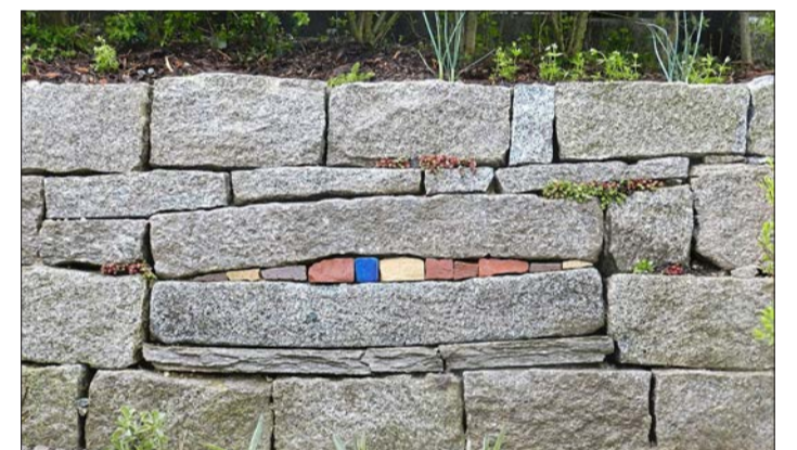
Eine Trockenmauer aus gebrauchten Natursteinstücken.
